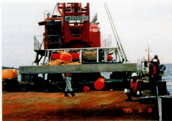
写真1 流速計の設置作業場面
