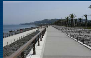
環境に配慮した護岸整備（横浜港）
