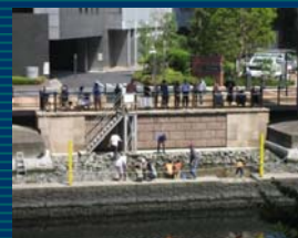
カ二護岸の整備（東京港）
