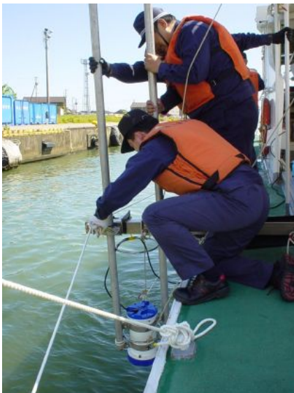
可搬型ADCP設置作業
