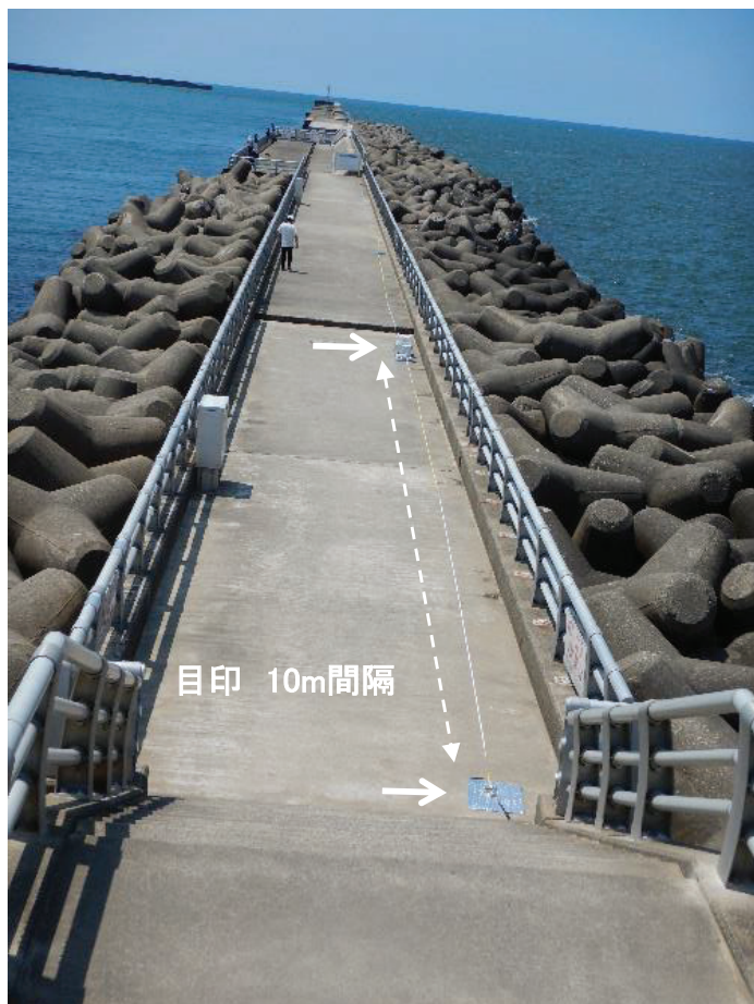
写真1 目印の設置状況
