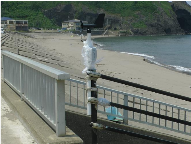
写真5 風向風速計の設置状況
