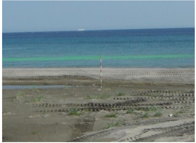
写真2 ポールの設置状況
