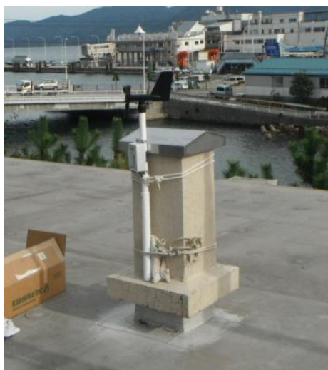
写真8 (風向風速計設置状況)
