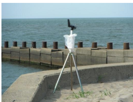
写真6 (固定式風向風速計設置状況)
