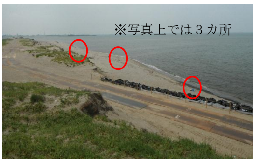
写真4 (三脚の設置状況)
