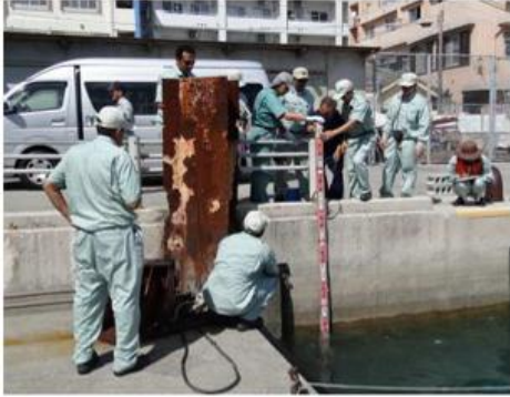
簡易驗潮器設置
